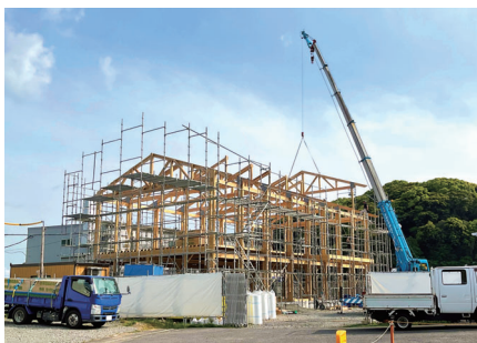
工事中のヒューマンティーパーク
