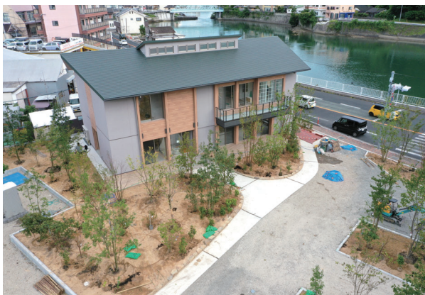
植栽工事の様子
