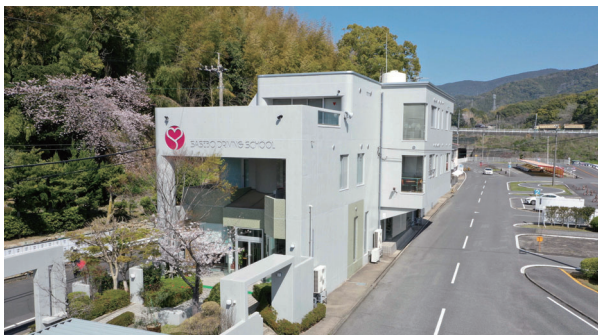
補修が完了した社屋
